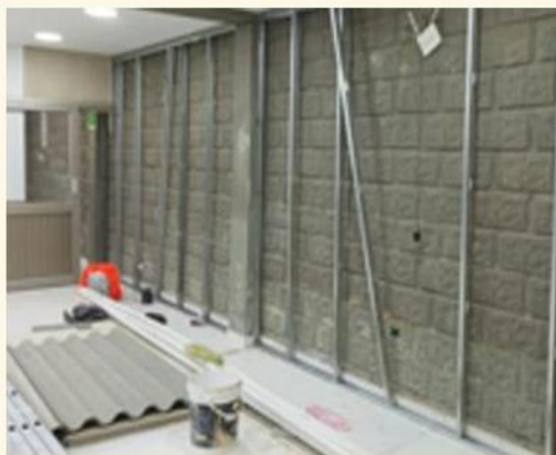
Adecuación — Sede Uribia
