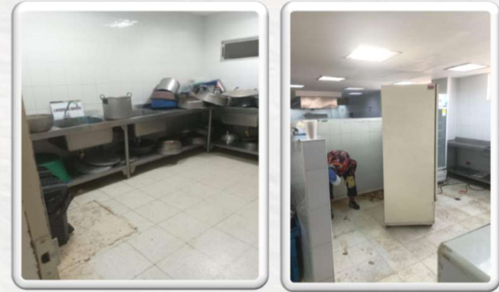
Área de cocina antes de la intervención.
