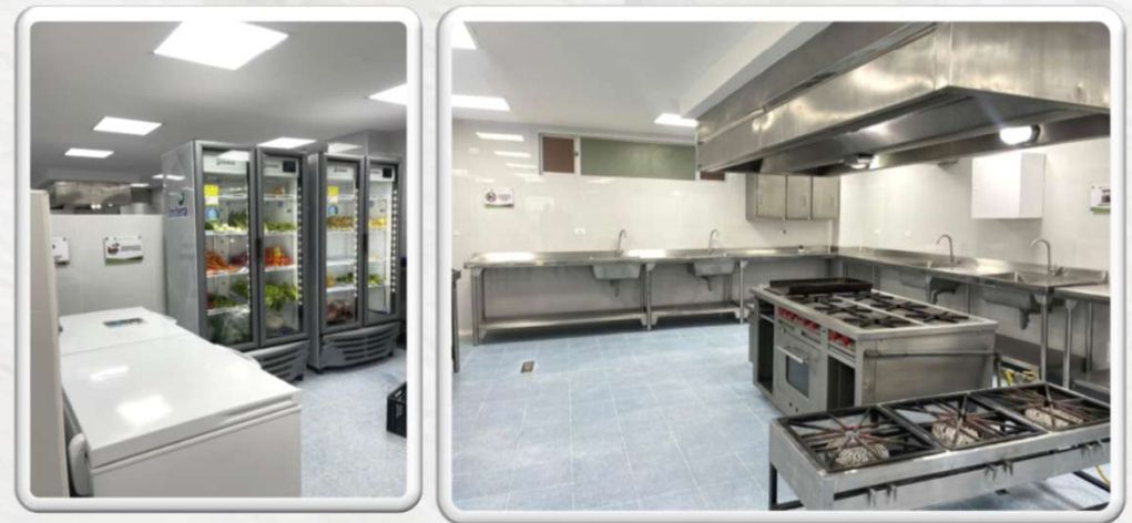
Área de cocina luego de la intervención en la vigencia 2024
