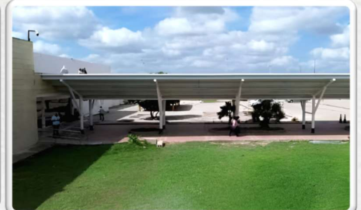
Acceso principal con la cubierta instalada en la vigencia 2024
